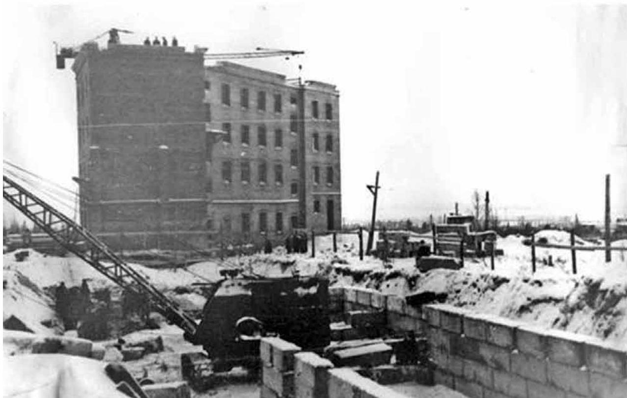
Закладка фундамента главного корпуса и строительство крыши первого жилого дома Академгородка, ул. Ферсмана, д. 16, зима 1956 г. Laying of main campus foundation and roof construction on first dwelling house in Akademgorodok, 16 Fersman Str., winter 1956.
