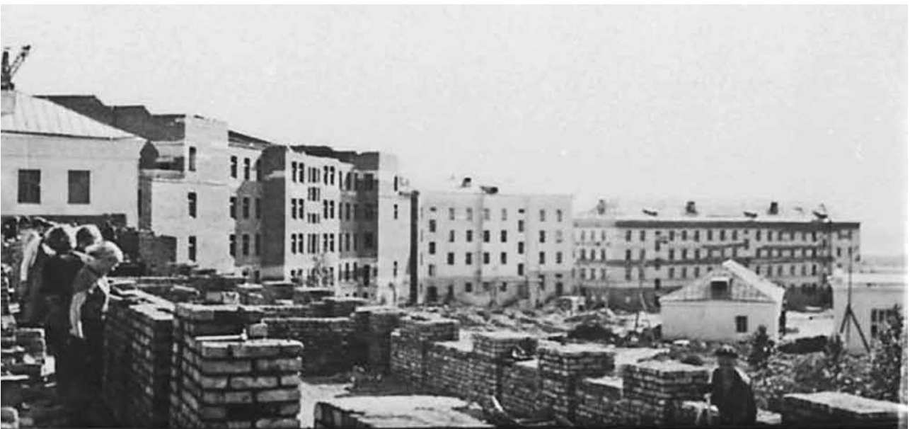
Строительство д. № 4 (ул. Ферсмана, д. 10). Лето 1960 г. Construction of build. No. 4 (10 Fersman Str.). Summer 1960.
