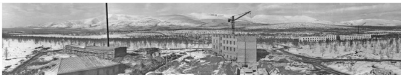
Панорама строительства Академгородка, справа – первые жилые дома Кировской ГРЭС по ул. Московской, зима 1956 г. Panorama of Akademgorodok construction, right – first dwelling houses of Kirovskaya Hydroelectric Power Station along Moskovskaya Str., winter 1956.
