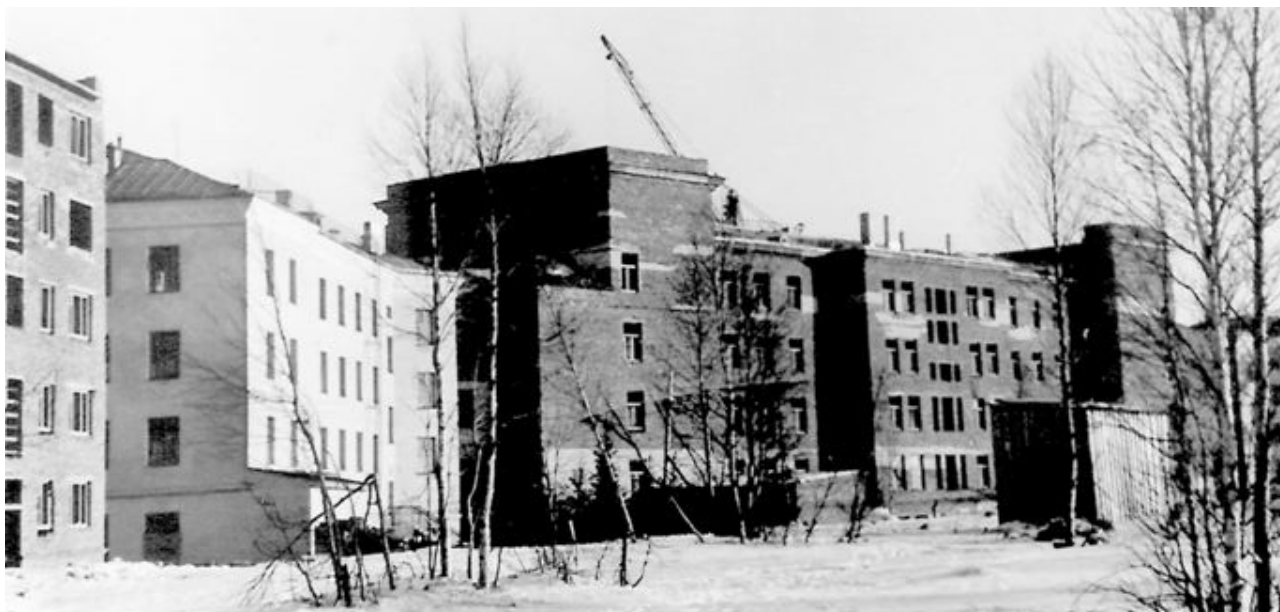
Завершение строительства главного корпуса и четырех жилых домов, весна 1961 г. Finishing construction of main campus and four dwelling houses, spring 1961.
