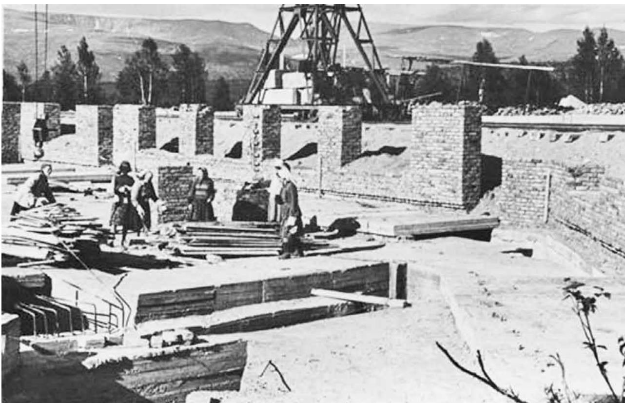
Бригада рабочих на строительстве первого жилого дома, ул. Ферсмана, д. 16, июль 1955 г. Work crew constructing first dwelling house, 16 Fersman Str., July 1955.
