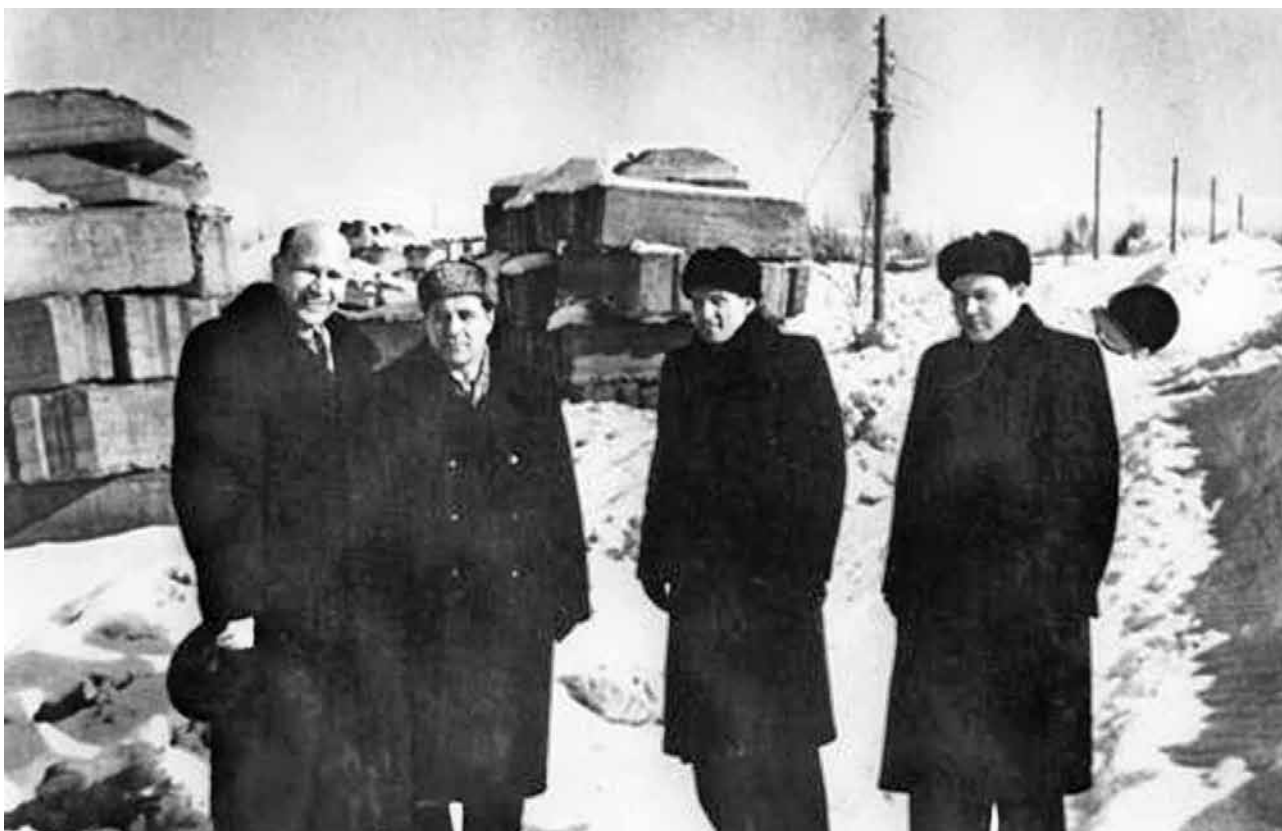
А.В. Сидоренко, В.И. Полтава, Н.В. Крынкин и Г.Д. Панасенко на строительстве Академгородка, весна 1956 г. A.V. Sidorenko, V.I. Poltava, N.V. Krynkin and G.D. Panasenko at construction of Akademgorodok, spring 1956.
