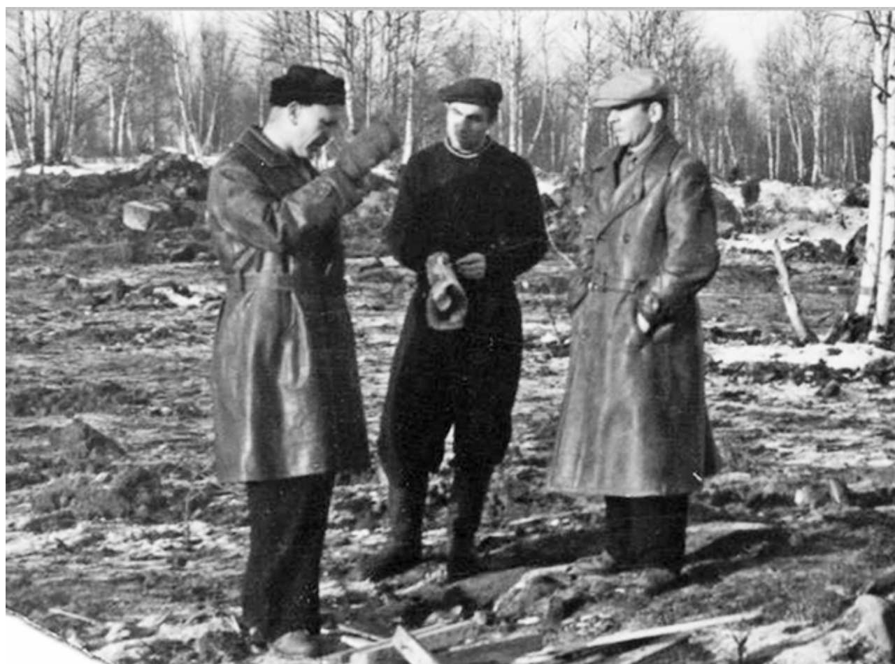
На месте будущего катка. А.В. Сидоренко обсуждает проект с В.А. Тюремовым и В.С. Ребенковым. Hockey rink to be on-site. A.V. Sidorenko discusses project with V.A. Tyuremnov and V.S. Rebenkov.
