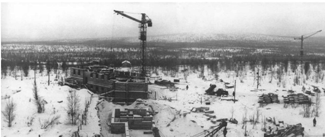
Закладка фундамента главного корпуса и строительство второго жилого дома, ул. Ферсмана, д. 12, зима 1956 г. Laying of main campus foundation and construction of second dwelling house, 12 Fersman Str., winter 1956.
