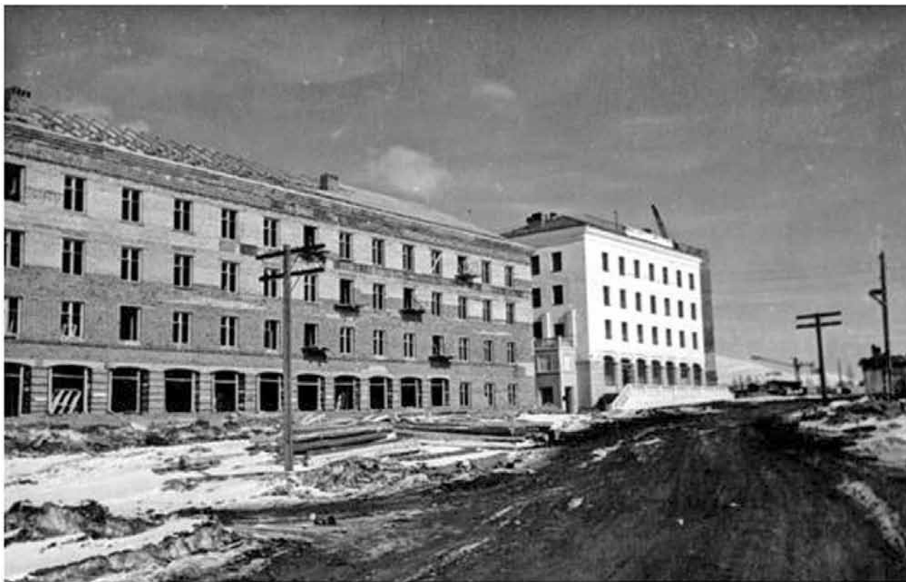
Строительство третьего жилого дома (ул. Ферсмана, д. 18), осень 1959 г. Construction of third dwelling house (18 Fersman Str.), autumn 1959.
