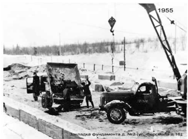
Закладка первого жилого дома, ул. Ферсмана, д. 16, начало 1955 г. Laying of first dwelling house foundation, 16 Fersman Str., early 1955.
