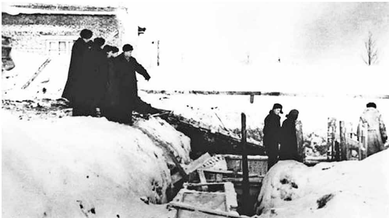
Закладка сейсмостанции. А.В. Сидоренко контролирует строительство. Весна 1956 г. Laying of seismic station. A.V. Sidorenko controls construction. Spring 1956.
