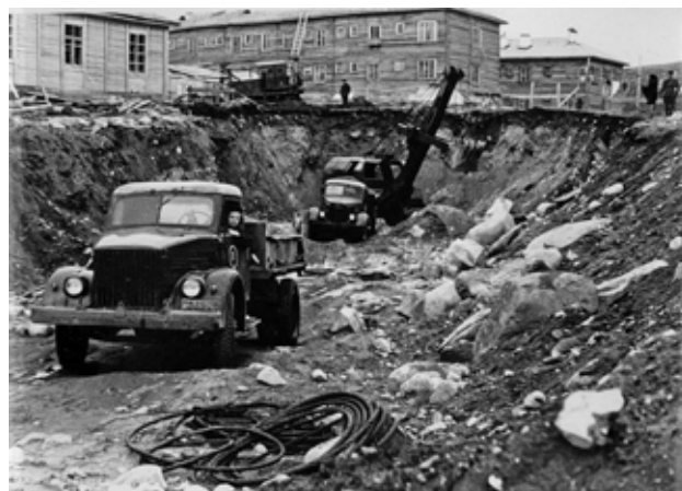
Котлован для корпуса крупного дробления. 1951 г. Cattle for crushing campus. 1951.
