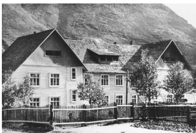
Посёлок Кукисвумчорр. Административное здание Кольской базы АН СССР, химико-аналитическая лаборатория, рентгено-спектральная лаборатория. В этом здании в 1951-1952 г. основан Геологический институт КФАН СССР. Kukisvumchorr settlement. Administrative building of USSR AS Kola Station, chemical-analytical laboratory, X-ray-spectral laboratory. Geological Institute KB USSR AS was established in 1951-1952.
