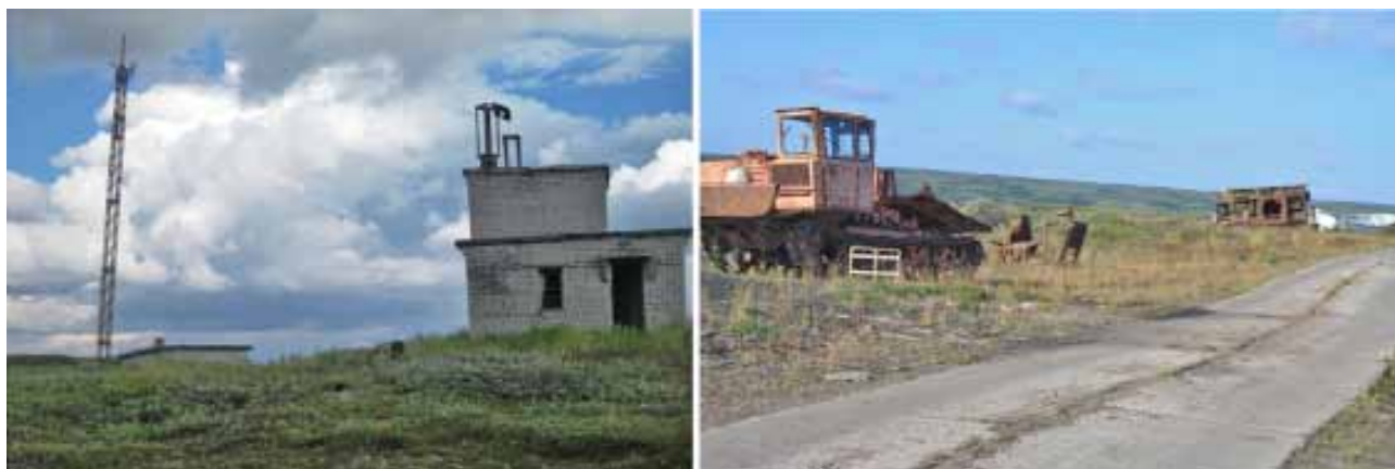
Рис. 2. Брошенная техника, остатки строений и коммуникаций. Fig. 2. Abandoned machines, remnants of constructions and infrastructure.
