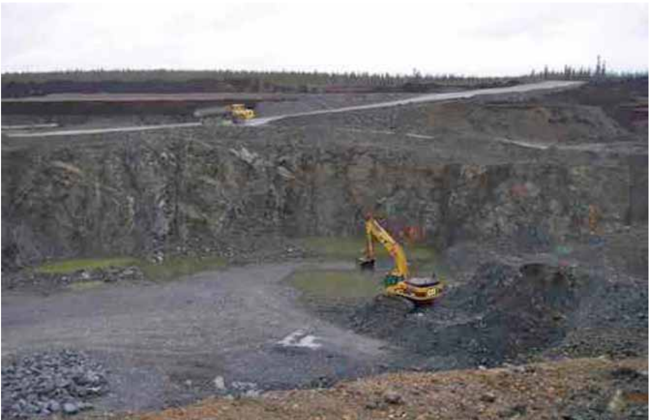
Fig. 5. Preparations for the open pit in Suurikuusikko, May 2007.
