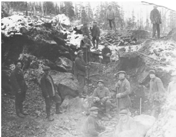
Рис. 6. Западный район. Проходка канавы. 1933 г. Из фондов музея ОАО «Апатит».
